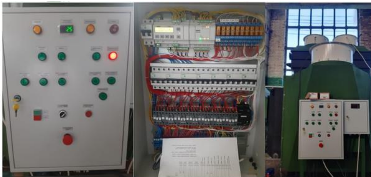
Рис. 4 Щит управления изготавливается с использованием контроллера ПР.200
